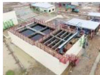
▲ティラワ工業団地ゾーンAに施工した浄水場
