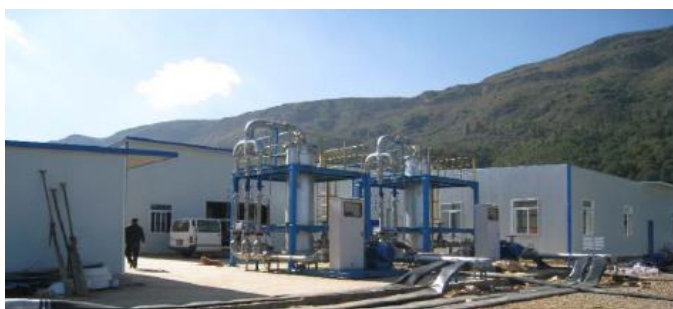
▲中国・滇池における実証事業の「オゾン処理等の水処理設備」
