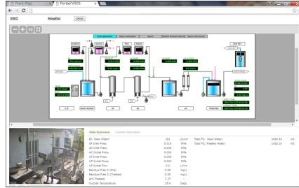
▲遠隔監視システムで現地状況を把握
