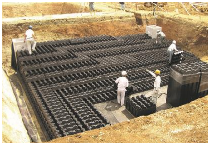
▲クロスウェーブ設置の様子
