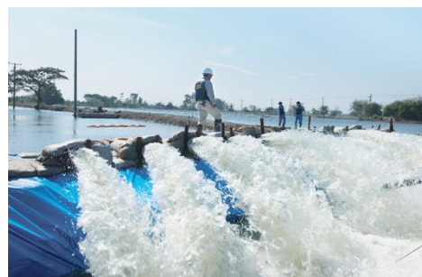
▲国際緊急援助隊による排水作業
