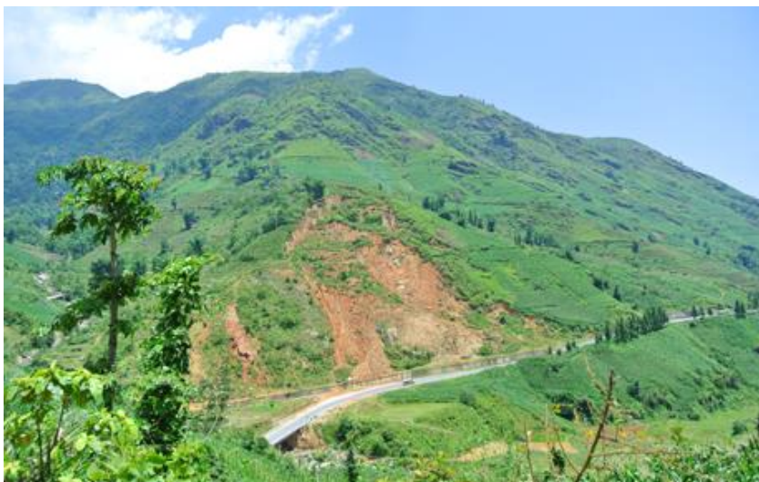
▲斜面防災が必要な現地の様子
