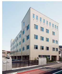
NR尾久ビル （東京都荒川区）
