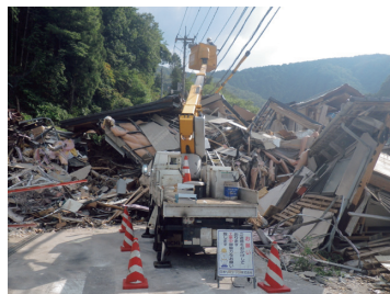
西日本豪雨災害復旧 (岡山県)
