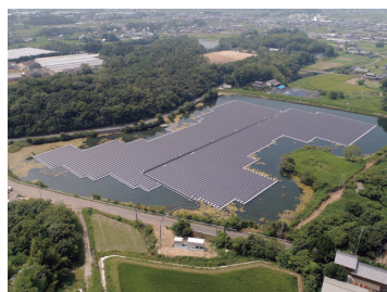
御田神辺池ソーラー発電所建設 (香川県)
