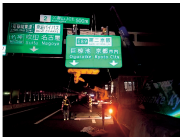
高速道路ナンバリング標識設置 (京都府)
