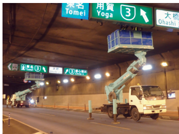
首都高速中央環状線標識補修 (東京都)
