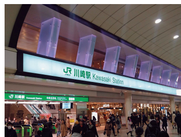
川崎駅自由通路電力設備新設 (神奈川県)
