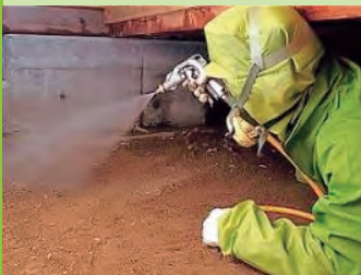
白蟻防除の施工
